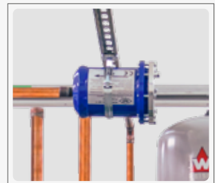
Komponenten fertig verrohrt
