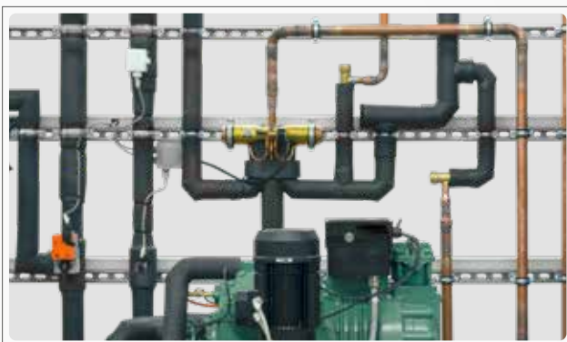
4-Wege Umkehrventil für Heiz- und Kühlbetrieb
