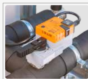
Leistungsregelung über Dreiwegeventil
