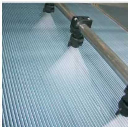
Lämmönsiirtimen kostututs ruiskusuuttimilla
