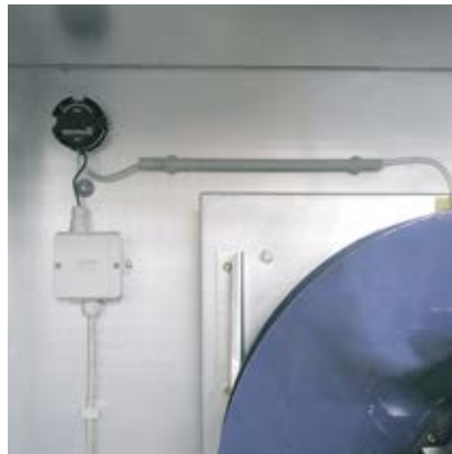
Tilavuusvirtamittari tuulettimessa
