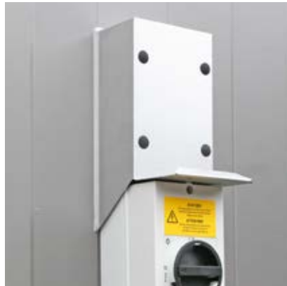
Korjauskytkimen säännestävä kotelointi
