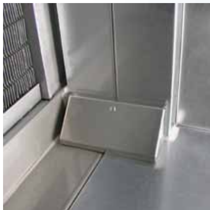
Behuizingsverbinding met afdekking
