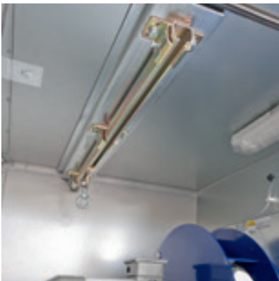
Utdragsskena för byte av fläkt
