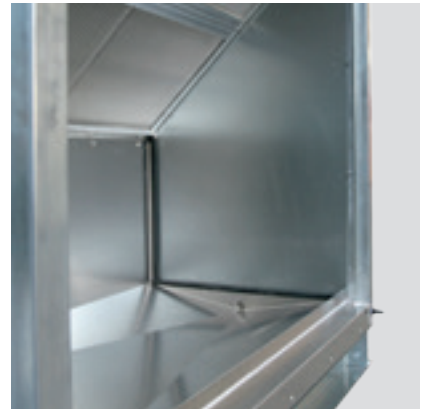
3D kondenstråget töms snabbt och fullständigt
