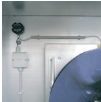
Mätning av volymströmmen på fläkten
