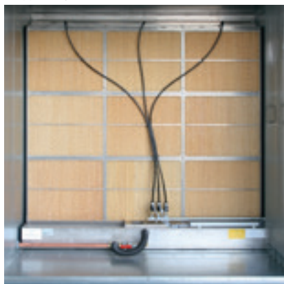
Kontakt befuktare med tre kaskader
