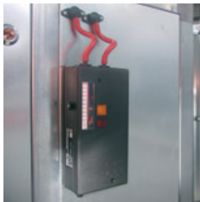
Manometer för tryckskillnad (filterövervakning)
