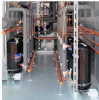
Direkt kylning med direktförångare
