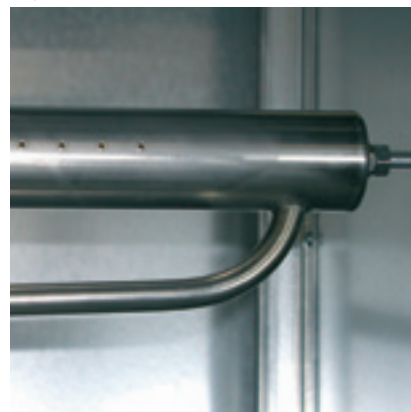
Ångspjut med kondensrör
