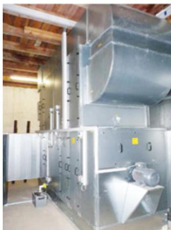
Abb. 3: Wärme- und Kondensatrückgewinnungs-Gerät
